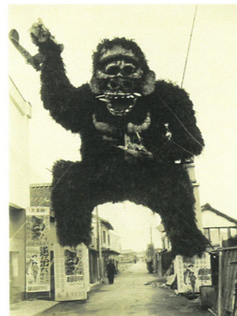
写真「観音寺市内のキングゴングの看板」 昭和29年(1954) 観音寺市ふるさと学芸館蔵
