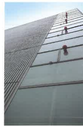
香川県文化会館 西側外壁
