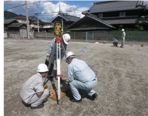
建設工事現場でのインターンシップ
