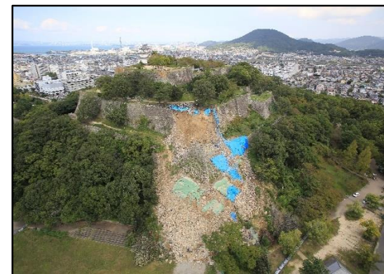
国指定史跡「丸亀城跡」(修理)
