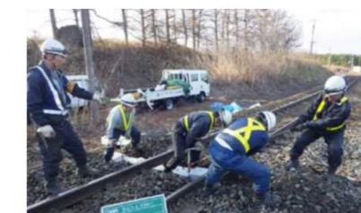
鉄道施設の設備投資や修繕
