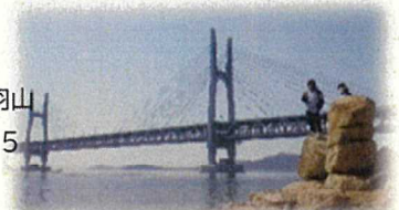
櫃石島斜張橋
