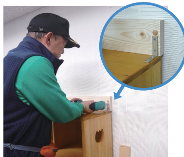
▲家具類転倒防止器具の取付け
