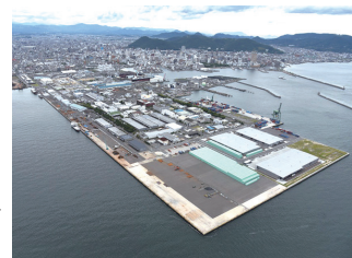
高松港の港湾整備
