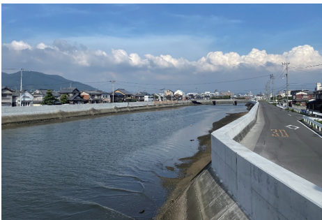
▲地震・津波対策(観音寺港)
