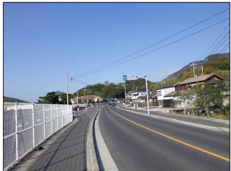
国道436号線(緊急輸送道路)
