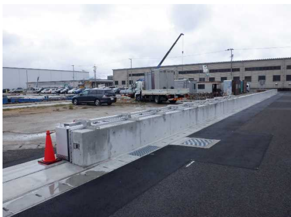
高松港朝日地区
