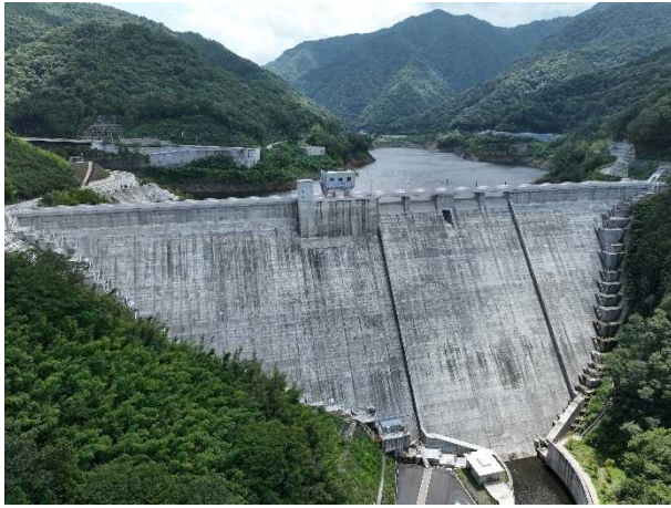
栂川ダム（ダム正面）
