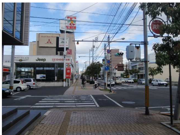
電線共同溝（整備前）
