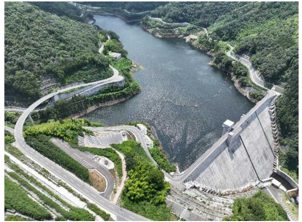
栂川ダム（貯水池全景）
