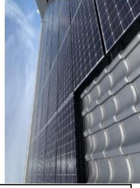
住宅用太陽光発電設備
