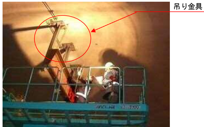
写真-解 6.3 触診作業状況
