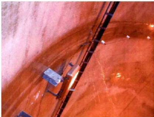
写真-解 7.7 漏水（噴出）している例
