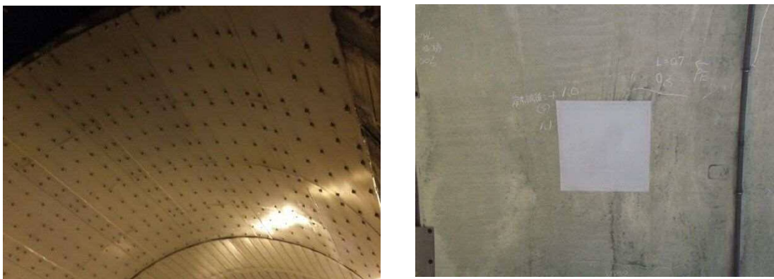
写真-解 7.10 鋼板接着 (左)・繊維シートの接着 (右) 例
