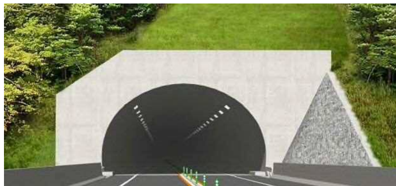
図-7.2 点検対象箇所（トンネル坑口部）
