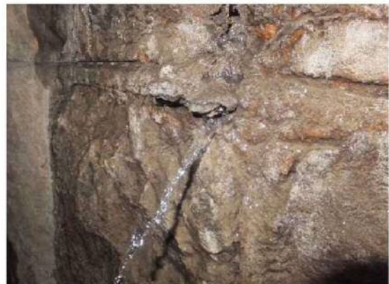
写真-解 7.7 漏水（噴出）している例
