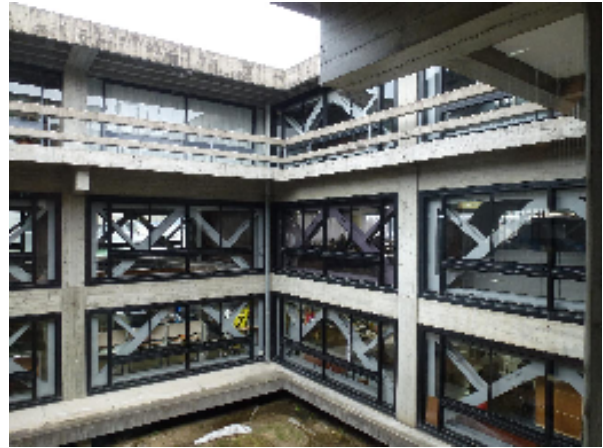
写真10 倉吉市庁舎 耐震施工例
