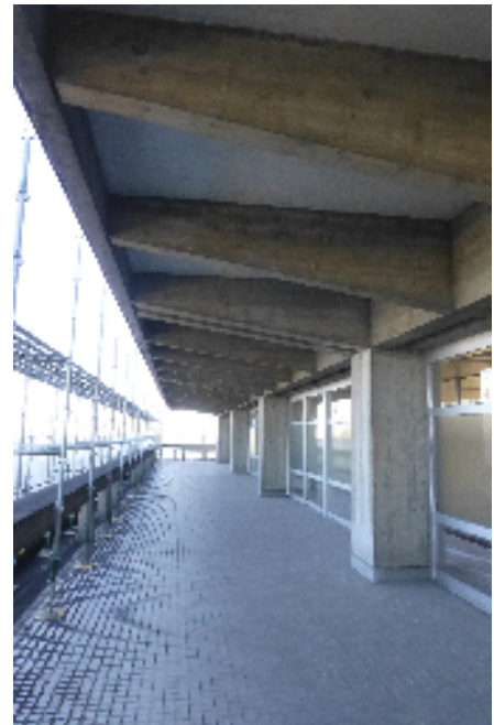
写真6 2階庇の大梁・小梁
