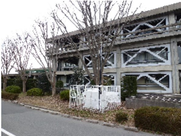
写真9 倉吉市庁舎 耐震施工例
