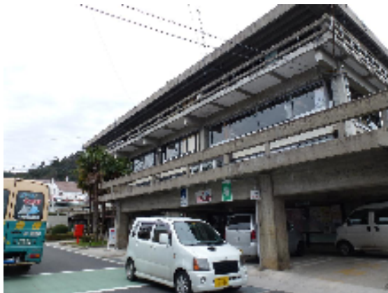
写真5 行政棟ベランダ下側の大梁と小梁
