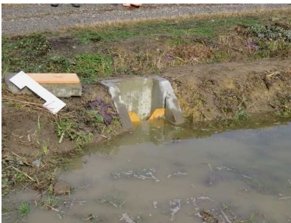
三角タイプにおける排水状況
