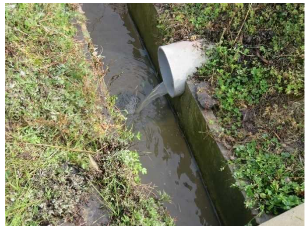
水路への排水状況
