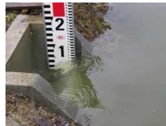
四角タイプの排水状況
