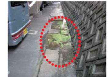
水がしみだしている擁壁 湧水部分にコケが生えている擁壁 (提供:公益社団法人 全国宅地擁壁技術協会)
