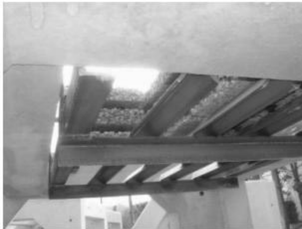
写真 5.6 多孔質体パネル装着状況(4)
