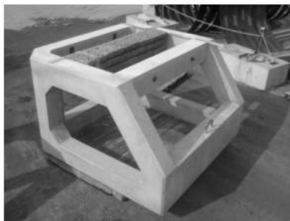
写真 5.3 多孔質体パネル装着状況(1)
