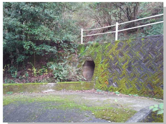
水路トンネル出口
