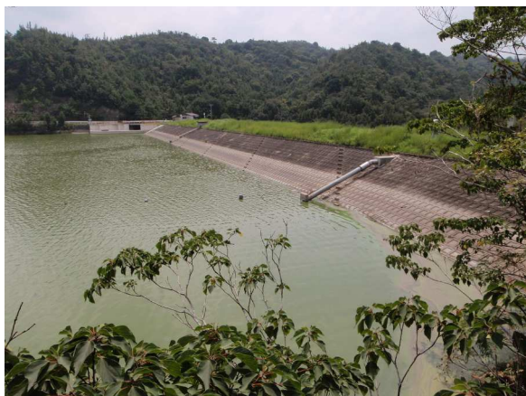
楠見池堤体の全景
