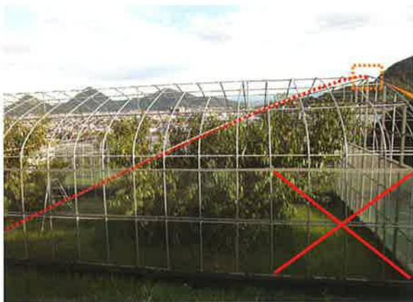
筋かい補強(点線)とクロス補強(実線)
