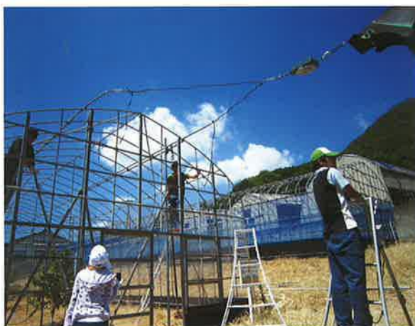
強度試験の様子(妻側からバックホーで引っ張る)
