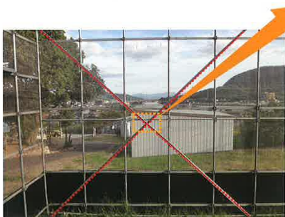
クロス補強の状況(上:サイド部、下:アーチ部)
