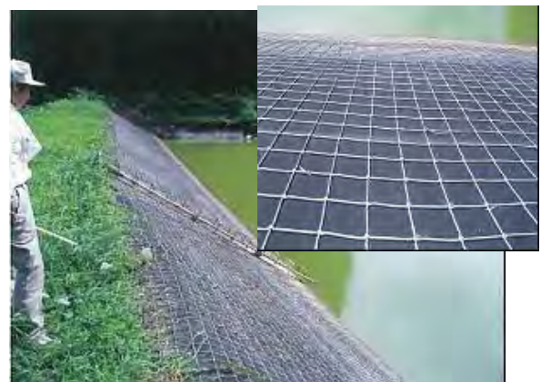
安全ネットの設置
