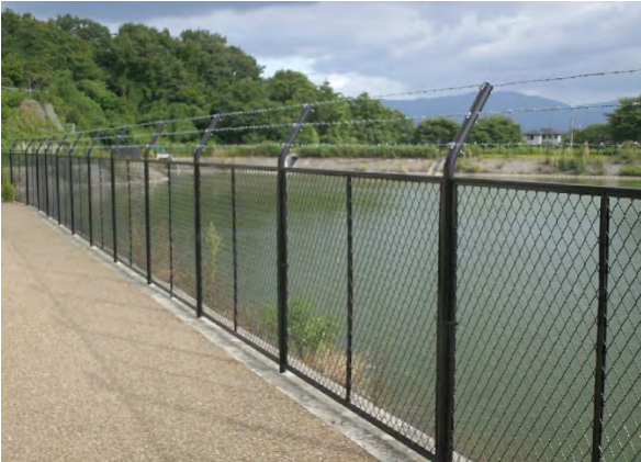
防護柵の設置
