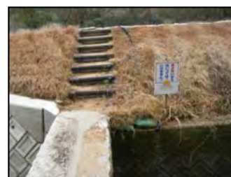
警告看板の設置
