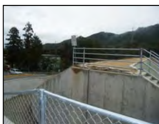
警告看板の設置
