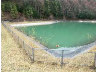
転落防止柵及び救助用ロープ並びに浮輪設置状況
