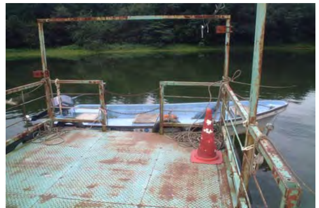
救命用ボートの常時設置
