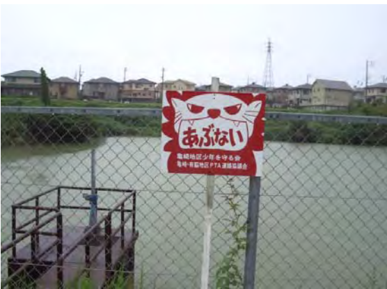
警告看板の設置②
