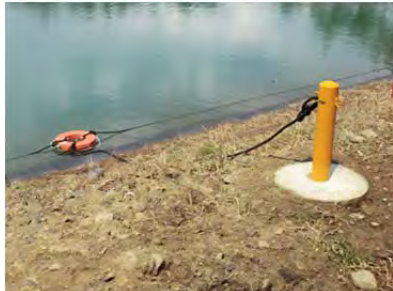
浮輪及び支柱設置状況
