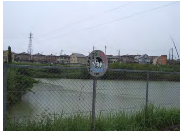
警告看板の設置③
