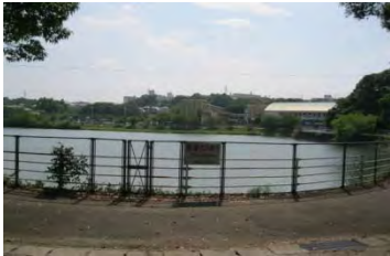
転落防止柵・警告看板の設置
