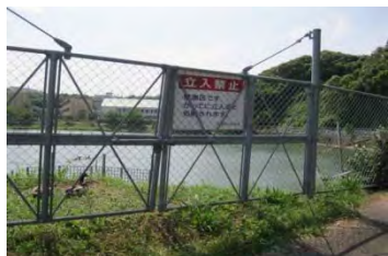
転落防止柵・警告看板の設置
