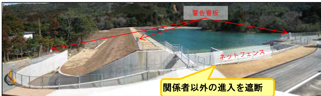
転落防止柵の設置
