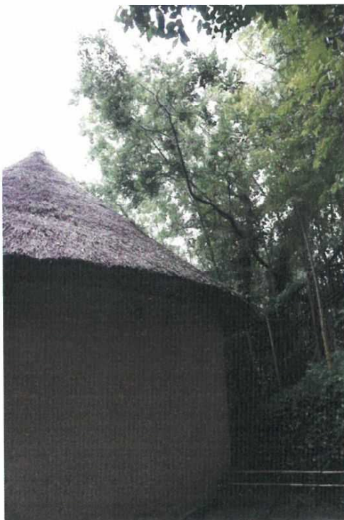
【外部樹木の様子】
