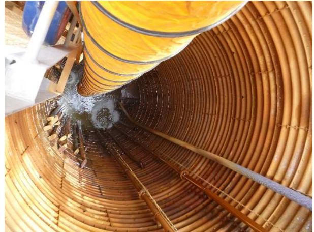
写真2 集水井内部の状況（R1.6.28）
