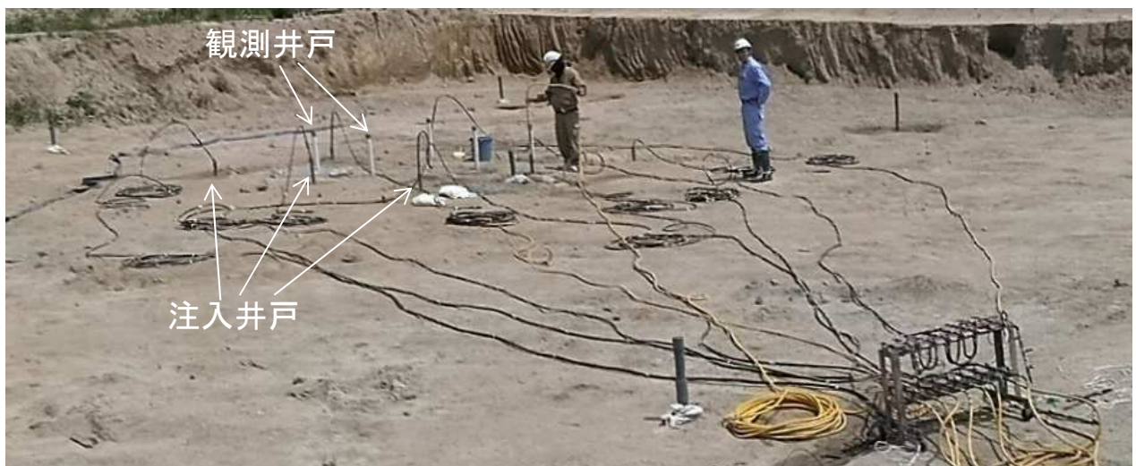
写真 1 ⑨-5 区画に注入状況
