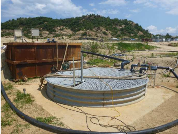
写真1 集水井の外観（R1.6.12）
