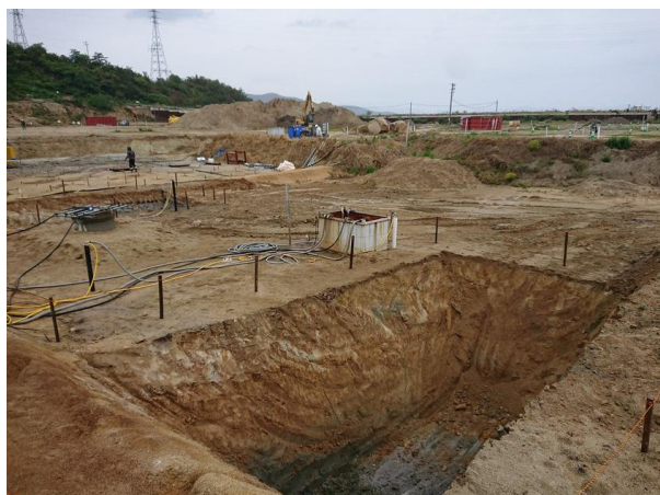
写真1 釜場の設置状況 (R3.5.12)
