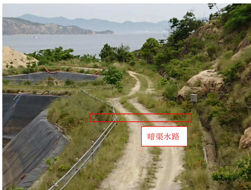
写真2 貯留トレンチへの導水方法
