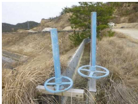
写真1 処分地進入路の排水路
