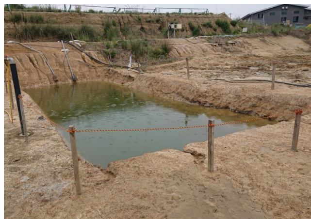
写真2 釜場からの注水の状況 (R3.5.24)
