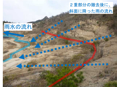
写真6 外周排水路（その2）
