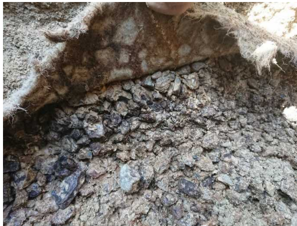
写真1 承水路下トレンチドレーン砕石 令和3年4月
