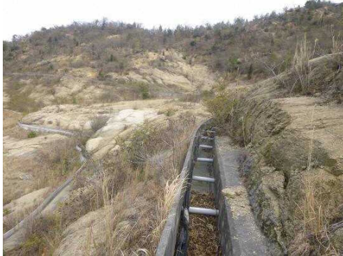
写真5 外周排水路（その1）
