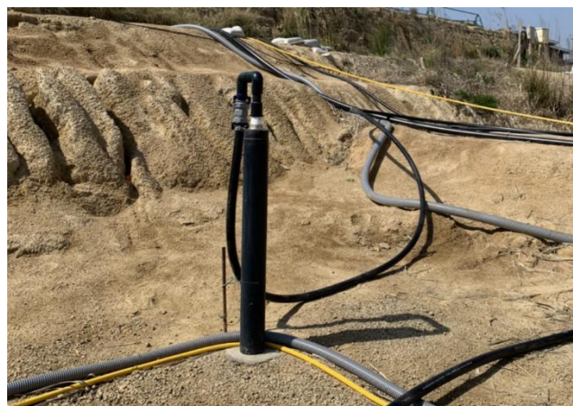
写真2 小区画㉔-7の注水の状況 (R3.4.21)
