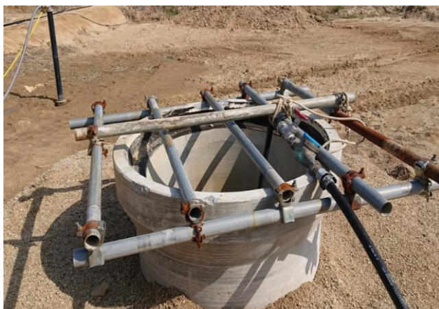
写真1 井戸側からの注水の状況 (R3.4.14)
