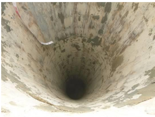
写真5 完掘時の状況
