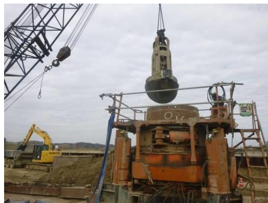
写真4 ハンマグラブによる掘削状況
