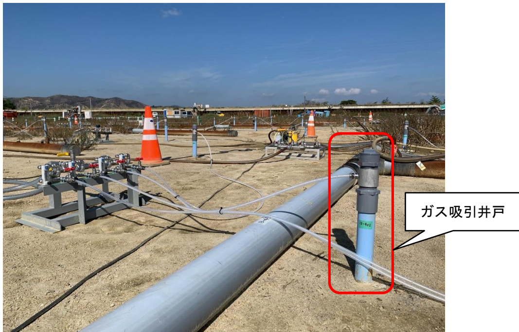
写真 1 ガス吸引の実施の状況
