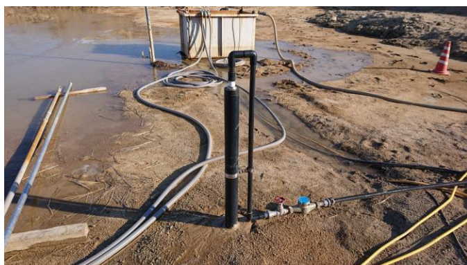
写真3 小区画㊸-8の注水井の状況
