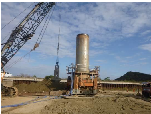
写真3 ケーシング管の建込状況
