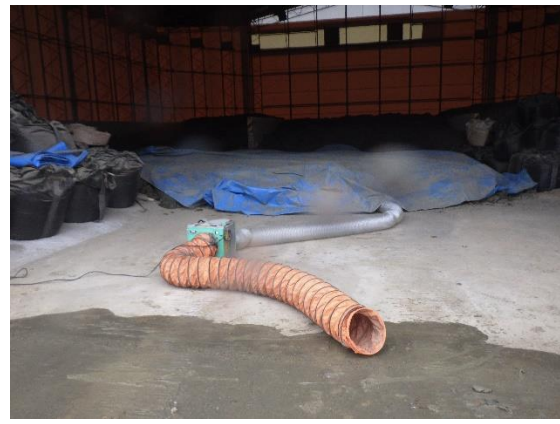
写真10 ガス吸引処理の状況
