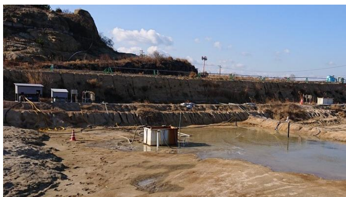
写真1 注水・揚水井による浄化対策の状況
