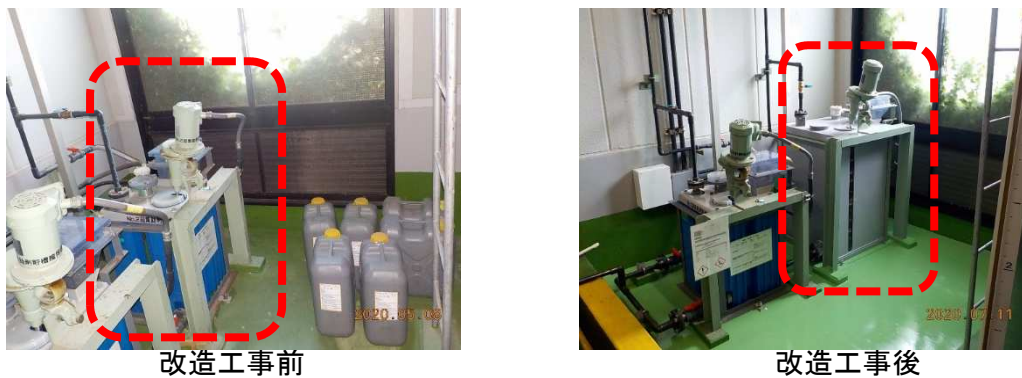
図3 ポリマー溶解槽の工事の状況
