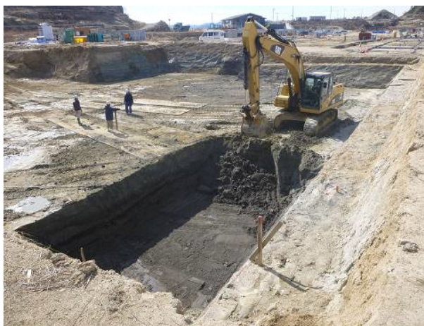
写真2 土壌掘削の状況（TP+0.75m→TP-1.25m）
