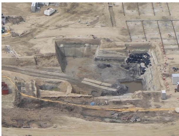
写真1 土壌掘削の状況（全景）
