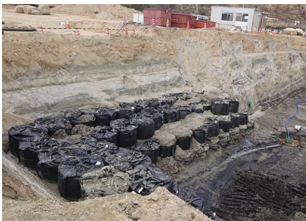
写真4 区画⑨-1北西側面の保護状況
