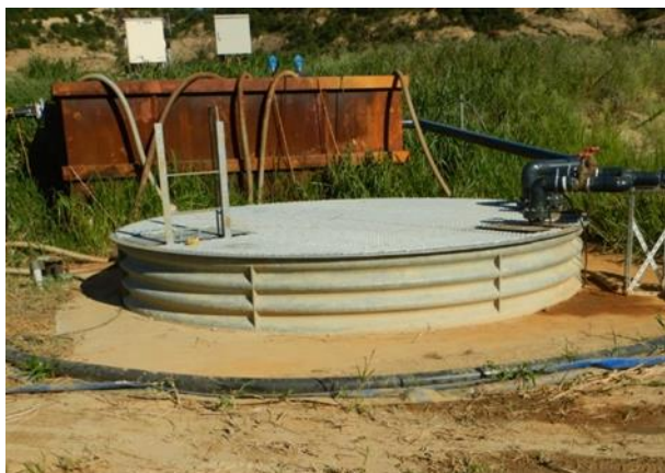
写真1 集水井の外観（R1.9.9）
