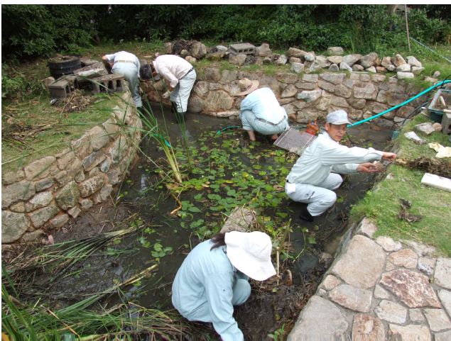
ビオトープ池補修作業風景(平成 18 年 8 月 2 日)
