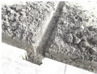
額縁明渠と排水溝を接続
