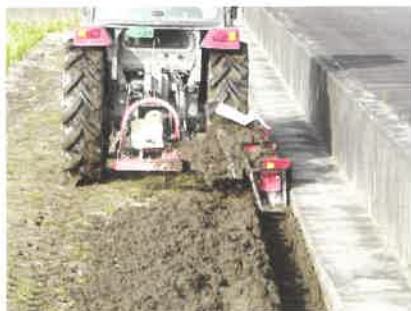
リターンデッチャーによる縁明渠の設置
