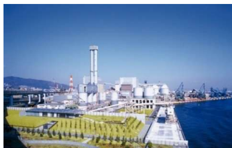
神鋼神戸発電所
