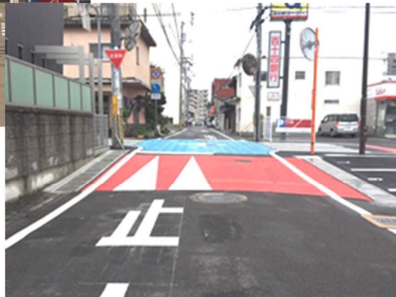
ハンプ施工後
