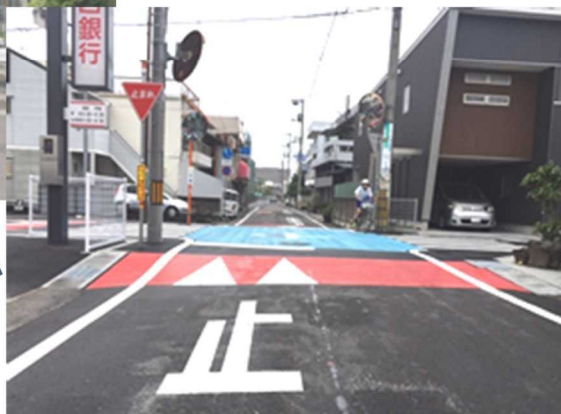
ハンプ施工後
