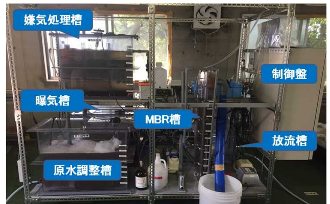
写真 1 実験装置を用いた総合排水の処理状況
