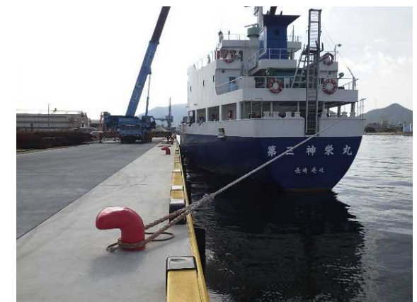
東運河岸壁増深部供用開始 (H30) -5.5m岸壁 L=100m
