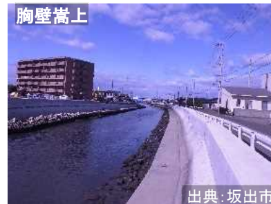
海岸堤防の対策例(高潮及び発生頻度の高い津波(L1))
