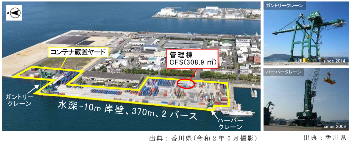
図表 1-36 コンテナターミナルの現況
