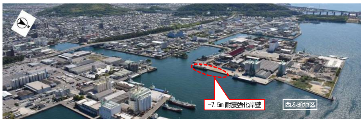
図表 1-69 坂出港の耐震強化岸壁
