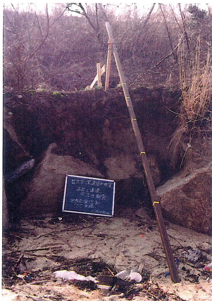
b) 簡易変位計の設置状況写真
