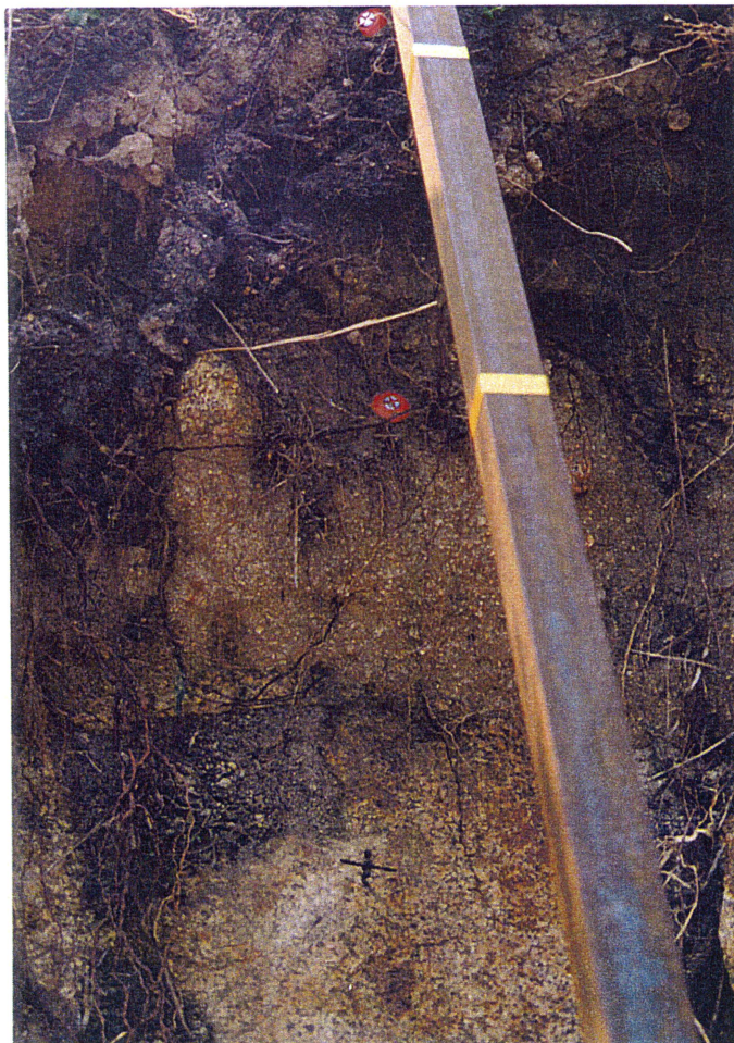
b) 簡易変位計設置状況写真
