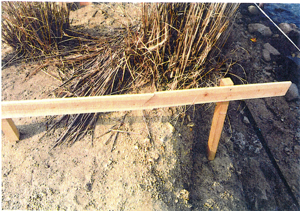
b) 簡易伸縮計設置状況写真
