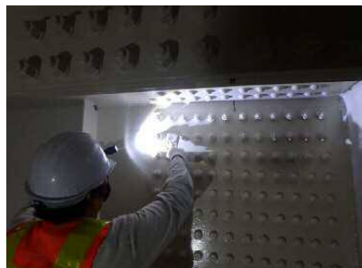
図 4.1 定期点検の様子
