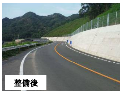
県道津田川島線(大川工区) 法面整備による落石等の防止対策
