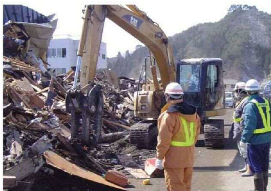
図 4-4 ガレキの撤去作業
