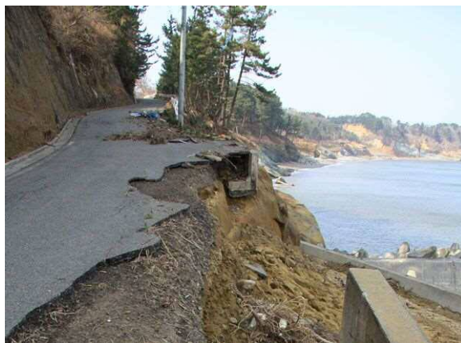
図 3-9 盛土法面崩落イメージ
