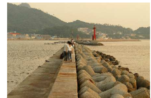
王の下沖防波堤 (高松市庵治町)
