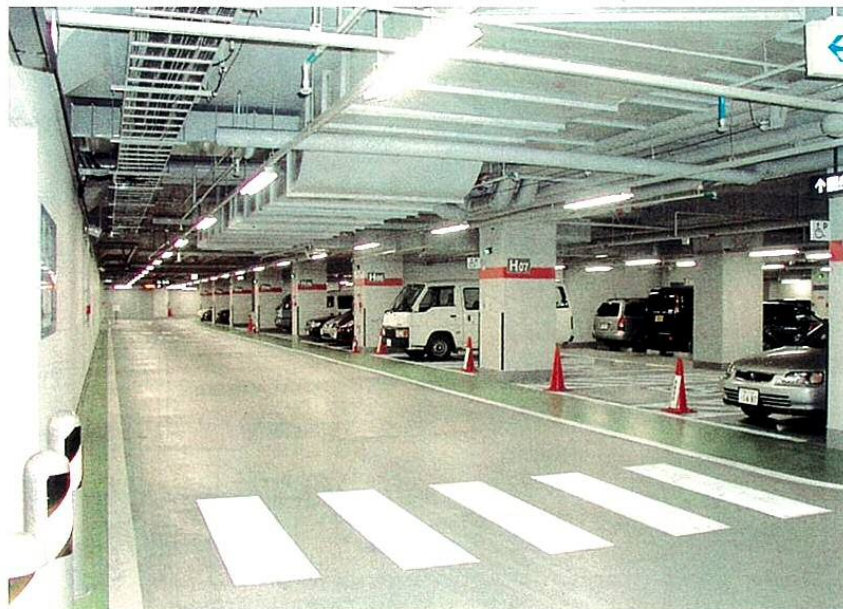
駅前広場地下駐車場
