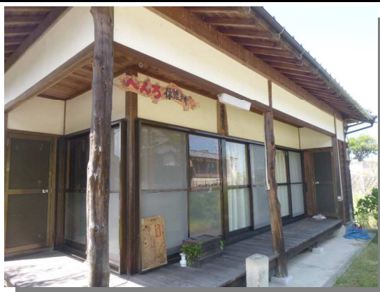
土佛観音院・へんろ休憩所
