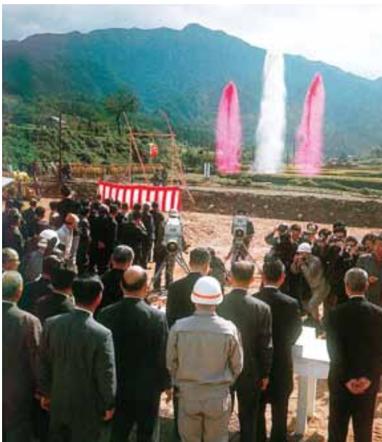
阿讃導水トンネルの香川県側(三豊市財田町)で挙行された 香川用水事業起工式 (昭和43年10月24日)
