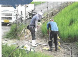
柵線20cm間隔をキープ 設置後すぐに通電開始
