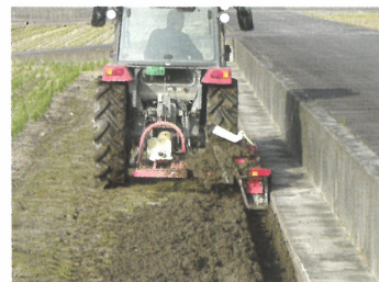
額縁明きよの設置
