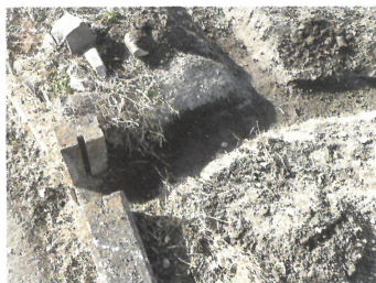
排水溝と落水口の連結
