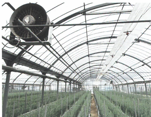
温度ムラ解消のための循環扇の設置
