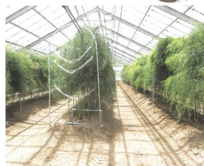
アスパラガス栽培ハウス
