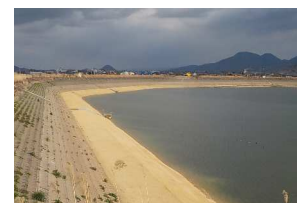
耐震化整備後のため池
