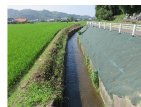
法面への防草シート施工
