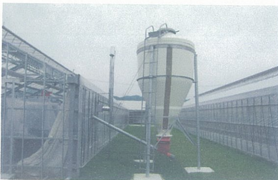
農業試験場への木質ペレットボイラーの設置
