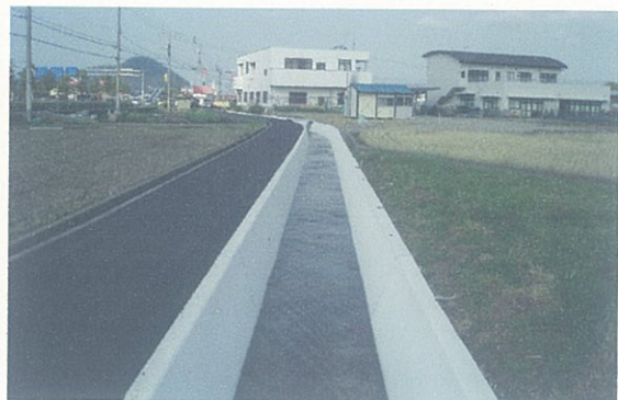
長寿命化対策後の農業用水路
