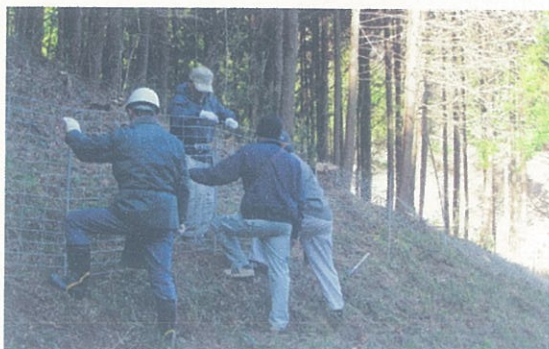
集落住民による侵入防止柵の設置
