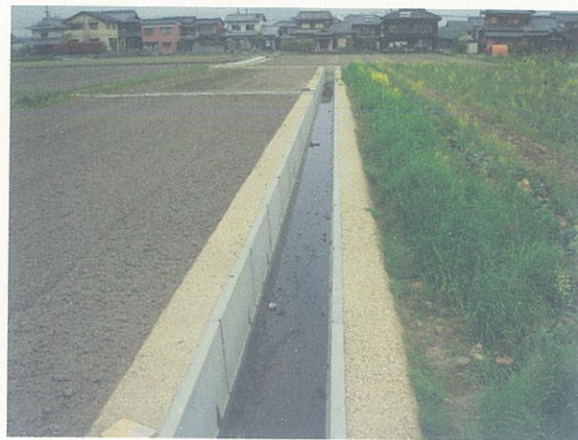
小規模な農業用水路の改修
